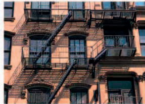
пожарный выход, пожарная лестница pozhar'niy vykhod, pozhar'naya lesnitsa fire escape
