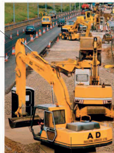
экскаватор ekskavator excavator
